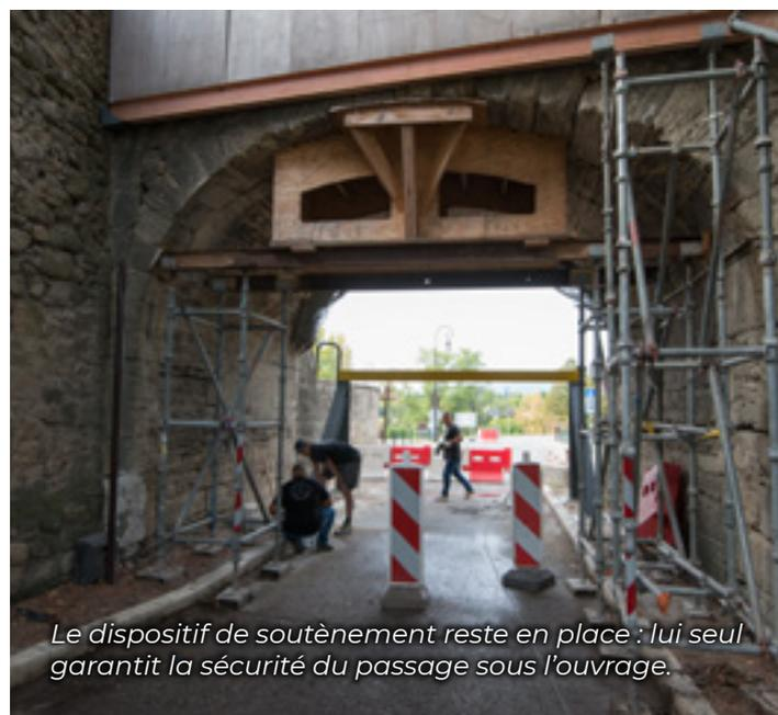
*Le dispositif de soutènement reste en place : lui seul garantit la sécurité du passage sous l'ouvrage.*
