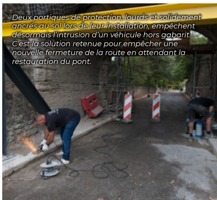
*Deux portiques de protection, lourds et solidement ancrés au sol lors de leur installation, empêchent désormais l'intrusion d'un véhicule hors gabarit. C'est la solution retenue pour empêcher une nouvelle fermeture de la route en attendant la restauration du pont.*
